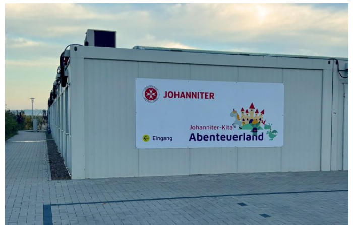
Hier ist die neue Kita in Modulbauweise zu sehen.
